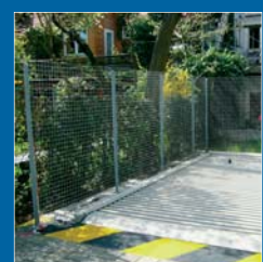
marking pit edge
