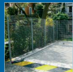
marking pit edge
