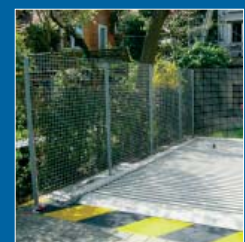
marking pit edge
