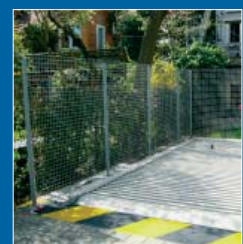
marking pit edge
